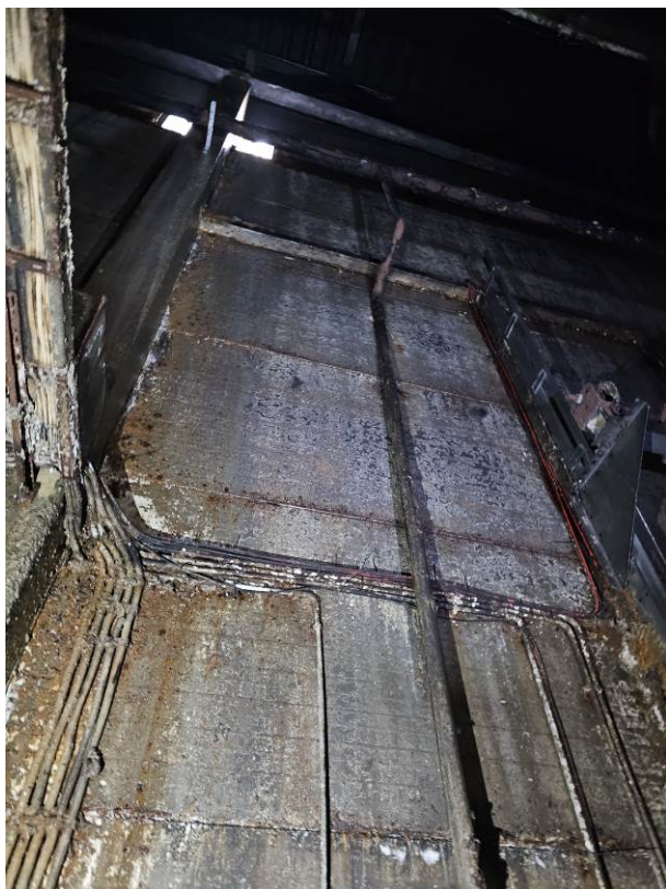
84 pav. Prie sieninių plokščių pritvirtinti elektros instaliacijos ir priešgaisrinės signalizacijos kabeliai
