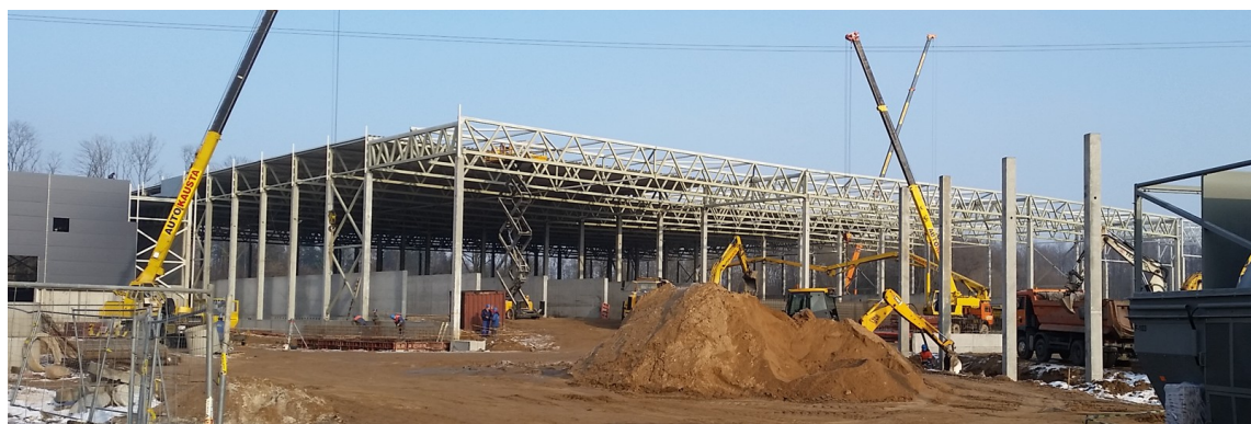
27 pav. Statinio plieninių konstrukcijų montavimas, 2015 m. vasario 4 d.
