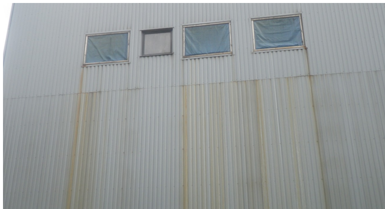
128 pav. Rūdžių tekėjimo pėdsakai ant dažytos skardos paviršiaus. 2023 m. balandžio mėn.
