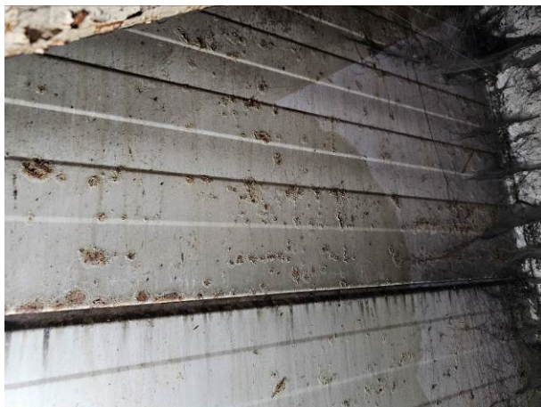
101 pav. Daugiasluoksnių plokščių vidinio paviršiaus taškinė korozija 22-oje tyrimų vietoje
