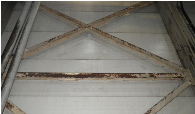
118 pav. Vartytuvo techninio aptarnavimo 1-3 patalpos kolonų plieninių ryšių (ramsčių) šoniniai paviršiai ir briaunos yra karodavusios. 2023 m. balandžio mėn.
