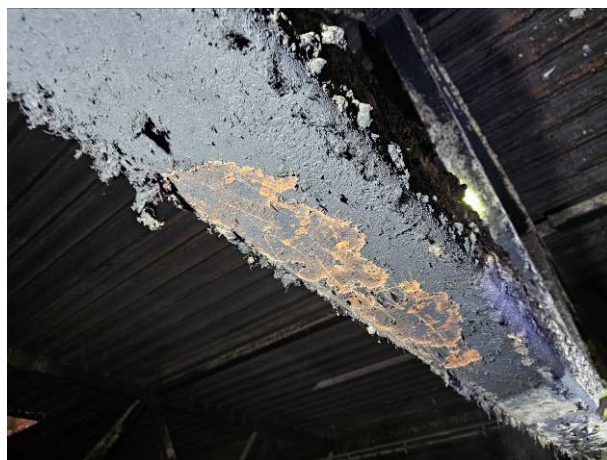
106 pav. Ištininė korozija santvaros paviršiuose 14-oje tyrimų vietoje
