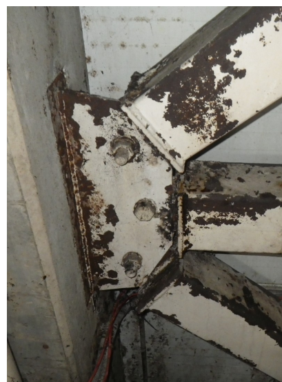
121 pav. Vartytuvo techninio aptarnavimo 1-3 patalpos ryšių (ramsčių) jungčių detalių karodavusieji paviršiai, varžtai, virintinės siūlės. 2023 m. balandžio mėn.
