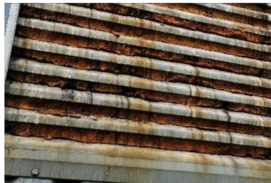
110 pav. Vėdinimo grotelės paveiktos korozijos, užsandarinti tarpeliai [nuotraukos darytos 2023 metais]
