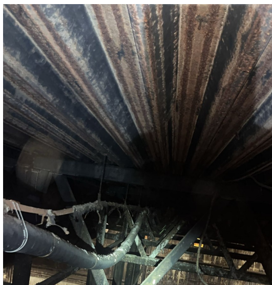
79 pav. Vaizdai iš 2025 m. rugsėjo–spalio mėn. aukštalipių fonuotraukų: inžinerinių tinklų vamzdžiai yra įlinkę; plieninio profiliuotojo pakloto paviršius yra aprūdijęs ir vietomis jau yra pasidaręs kiauras; inžinerinių tinklų tvirtinimai pažeisti korozijos
