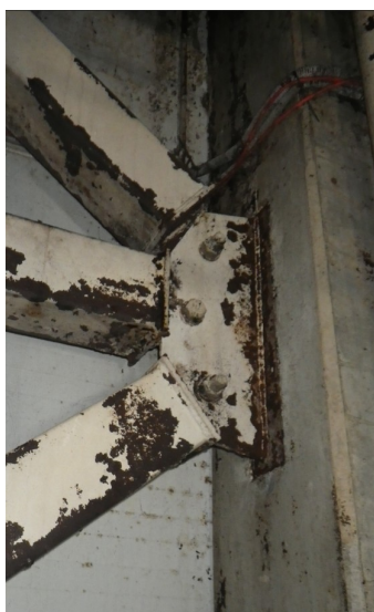
121 pav. Vartytuvo techninio aptarnavimo 1-3 patalpos ryšių (ramsčių) jungčių detalių karodavusieji paviršiai, varžtai, virintinės siūlės. 2023 m. balandžio mėn.
