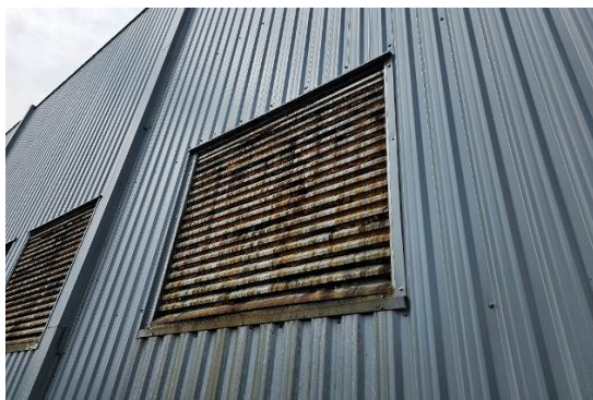
110 pav. Vėdinimo grotelės paveiktos korozijos, užsandarinti tarpeliai [nuotraukos darytos 2023 metais]
