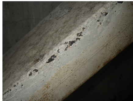
123 pav. Taškinė korozija ant plieninių ramsčių (ryšių) išilgai briaunų. 2023 m. balandžio mėn.
