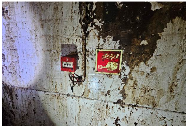
83 pav. Prie sieninių plokščių pritvirtinta priešgaisrinė signalizacija
