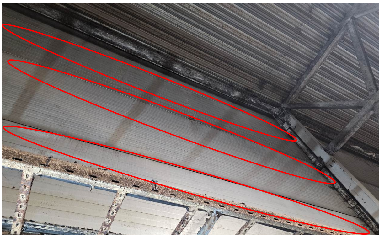
103 pav. Išsigaubusios sieninės plokštės 22-oje tyrimų vietoje (raudonai apibrėžtos sieni- nių plokščių horizontalios siūlės, kurios deformuotos ir išsilenkusios į patalpų pusę)
