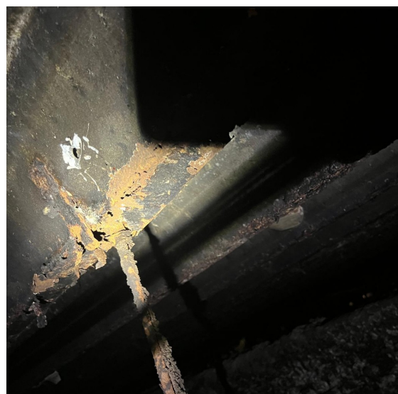
79 pav. Vaizdai iš 2025 m. rugsėjo–spalio mėn. aukštalipių fonuotraukų: inžinerinių tinklų vamzdžiai yra įlinkę; plieninio profiliuotojo pakloto paviršius yra aprūdijęs ir vietomis jau yra pasidaręs kiauras; inžinerinių tinklų tvirtinimai pažeisti korozijos
