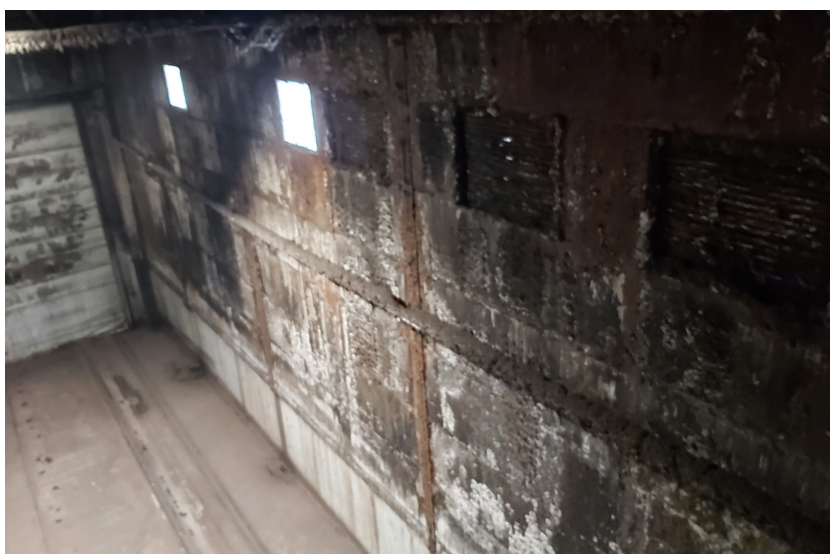
21 pav. Sienos ašyje „2A“ paviršiaus bendrasis vaizdas: nusilupę dažai; rūdijimo paveikti ruožai, siena padengta apnašu, 2026 m. vasario 19 d.
