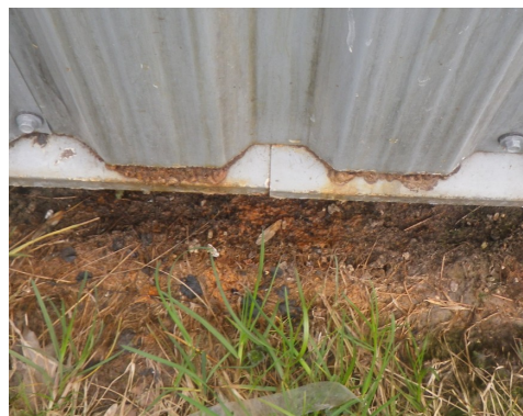
129 pav. Fasadinės sienos apačioje kondensatas su korozijos produktais laša ant grunto, čia neauga žolė. 2023 m. balandžio mėn.
