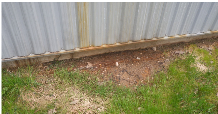
129 pav. Fasadinės sienos apačioje kondensatas su korozijos produktais laša ant grunto, čia neauga žolė. 2023 m. balandžio mėn.
