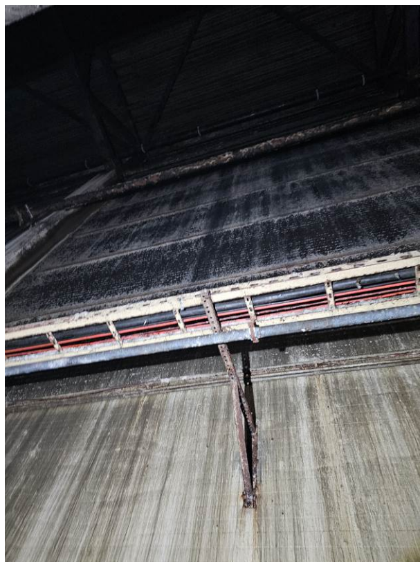
84 pav. Prie sieninių plokščių pritvirtinti elektros instaliacijos ir priešgaisrinės signalizacijos kabeliai
