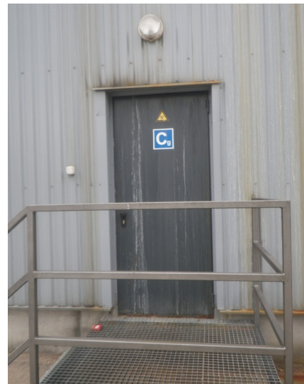
130 pav. Pastato durys yra pasidengusios baltais (iš susikondensavusių organinių medžiagų sudarytais) ruožais. 2023 m. balandžio mėn.
