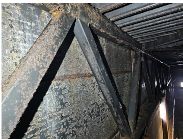
100 pav. Daugiasluoksnių plokščių vidinio paviršiaus taškinė korozija 7-oje tyrimų vietoje
