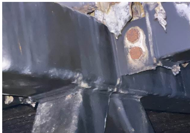
109 pav. Ištininė korozija, kuri veikia stogo plieninių konstrukcijų varžtines jungtis
