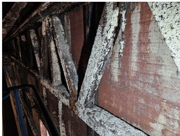
98 pav. Daugiasluoksnių plokščių vidinio paviršiaus ištisinė korozija 20-oje tyrimų vietoje
