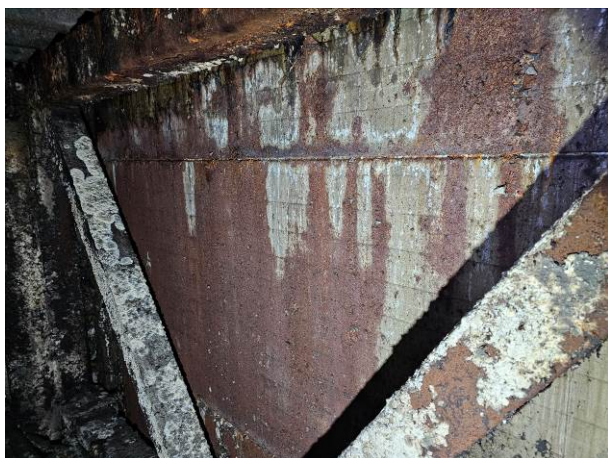
98 pav. Daugiasluoksnių plokščių vidinio paviršiaus ištisinė korozija 20-oje tyrimų vietoje
