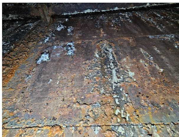
96 pav. Daugiasluoksnių plokščių vidinio paviršiaus ištisinė korozija 19-oje tyrimų vietoje
