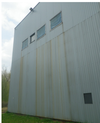
128 pav. Rūdžių tekėjimo pėdsakai ant dažytos skardos paviršiaus. 2023 m. balandžio mėn.
