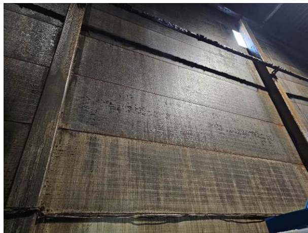
81 pav. Statinio sienos ašyse „19“, „22“, „2P“, „2A“, „2C“ ir „27“ įrengtos iš daugiasluoksnių plokščių su termoizoliaciniu užpildu
