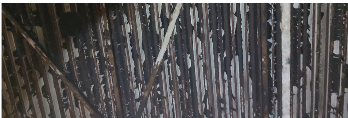
18 pav. Stogo plieninio profiliuotojo pakloto paviršiaus bendrasis vaizdas: nusilupę dažai; rūdijimo paveikti ruožai, 2025 m. spalio 14 d.
