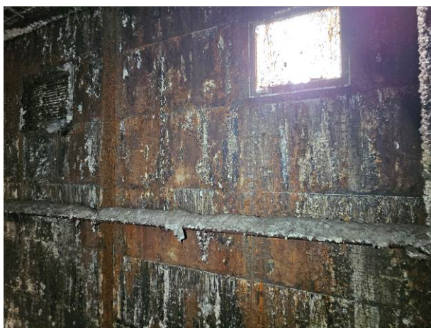
96 pav. Daugiasluoksnių plokščių vidinio paviršiaus ištisinė korozija 19-oje tyrimų vietoje
