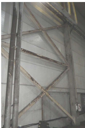
118 pav. Vartytuvo techninio aptarnavimo 1-3 patalpos kolonų plieninių ryšių (ramsčių) šoniniai paviršiai ir briaunos yra karodavusios. 2023 m. balandžio mėn.
