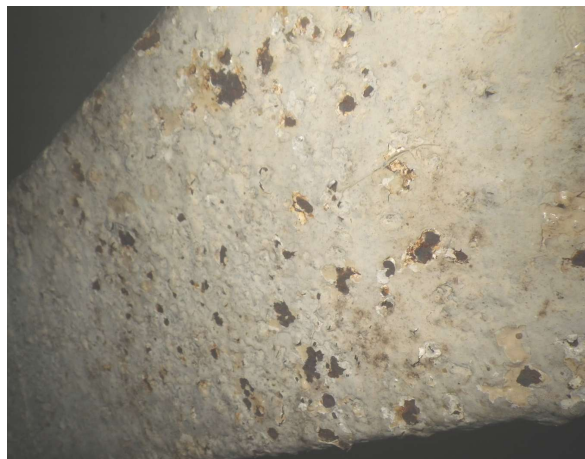
122 pav. Taškinė korozija ant plieninių ramsčių (ryšių). 2023 m. balandžio mėn.
