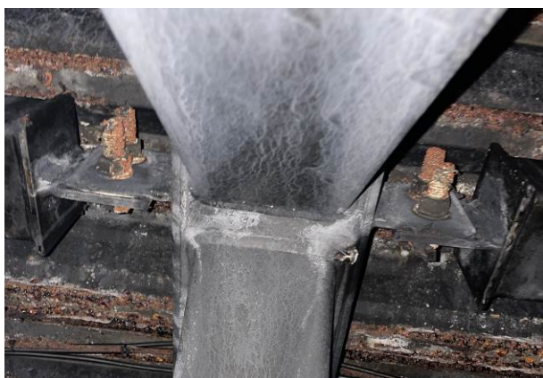
109 pav. Ištininė korozija, kuri veikia stogo plieninių konstrukcijų varžtines jungtis
