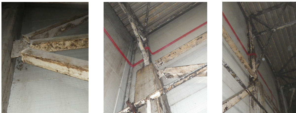
124 pav. Taškinė korozija ant plieninių ramsčių (ryšių) išilgai briaunų. 2023 m. balandžio mėn.
