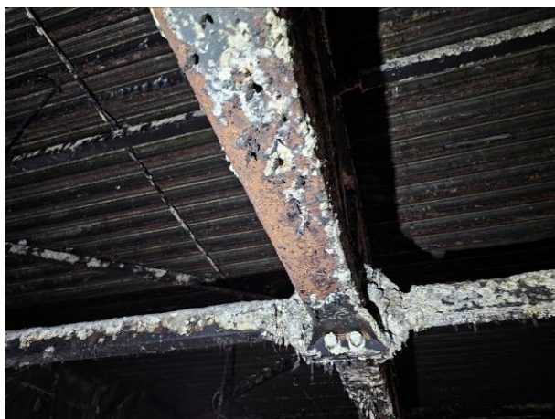
105 pav. Ištininė korozija santvaros paviršiuose 14-oje tyrimų vietoje
