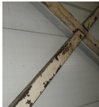
119 pav. Vartytuvo techninio aptarnavimo 1-3 patalpos kolonų plieninių ryšių (ramsčių) šoniniai paviršiai ir briaunos yra karodavusios. 2023 m. balandžio mėn.
