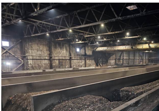
80 pav. Statinio stogo laikančioji konstrukcija sudaryta iš plieninių stogo santvarų, posantvarių, santvarų viršutines bei apatines juostas apjungiančių tiesių ir įstrižų plieninių ryšių-ramsčių
