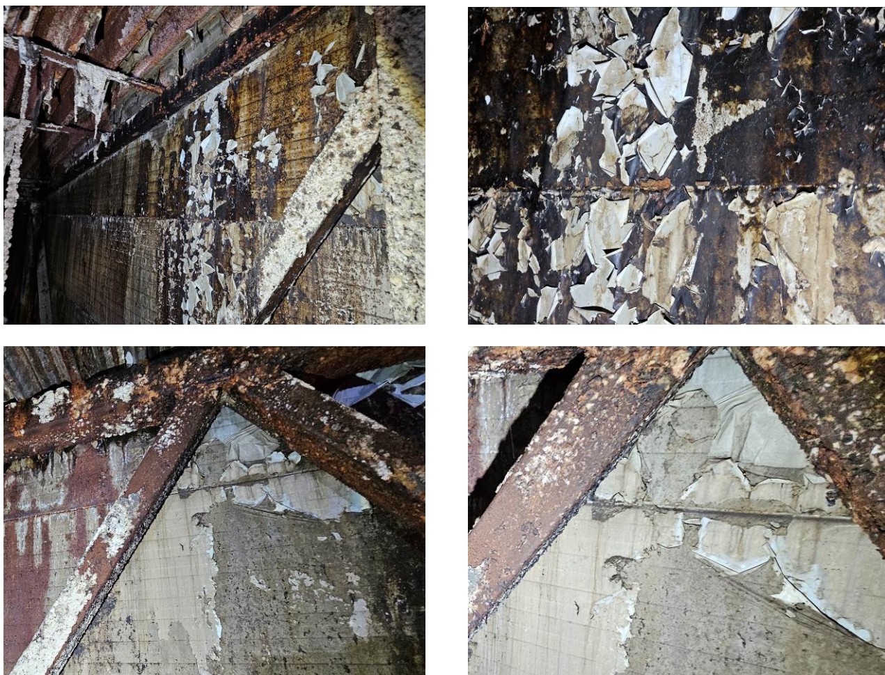
95 pav. Daugiasluoksnių plokščių vidinio paviršiaus dažų sluoksnis lupasi ir krenta žemyn
