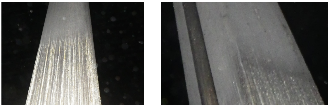
134 pav. Tekėjimo pėdsakams konstrukcijų aukštyje yra būdinga riba, nuo kurios jie susidaro ir teka žemyn. 2023 m. balandžio mėn.
