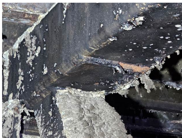
108 pav. Ištininė korozija stogo plieninių santvarų suvirinimo siūlėse
