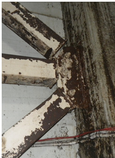
121 pav. Vartytuvo techninio aptarnavimo 1-3 patalpos ryšių (ramsčių) jungčių detalių karodavusieji paviršiai, varžtai, virintinės siūlės. 2023 m. balandžio mėn.
