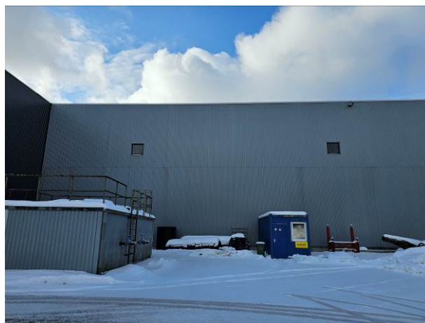
82 pav. Statinio fasadų fragmentai, įrengti iš trapecinio profilio skardos lakštų
