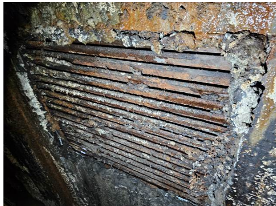
112 pav. Surūdijusios vėdinimo grotelės sienose iš patalpų pusės (2026 m.)
