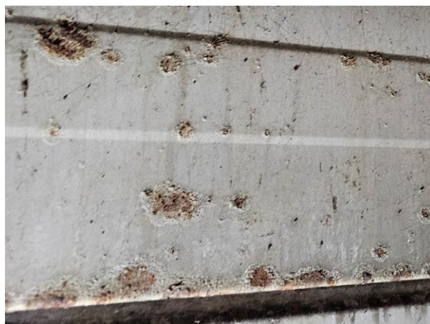
101 pav. Daugiasluoksnių plokščių vidinio paviršiaus taškinė korozija 22-oje tyrimų vietoje
