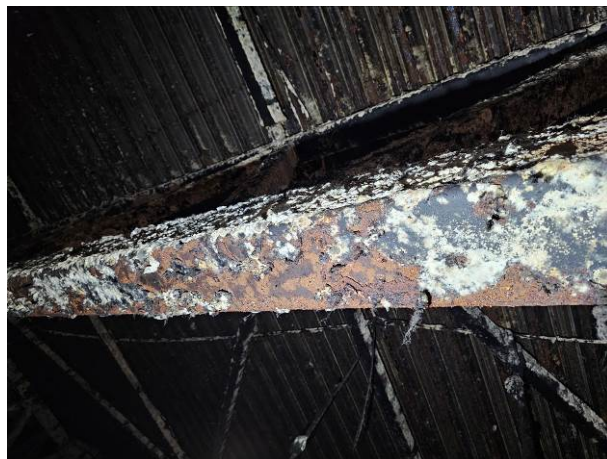
105 pav. Ištininė korozija santvaros paviršiuose 14-oje tyrimų vietoje
