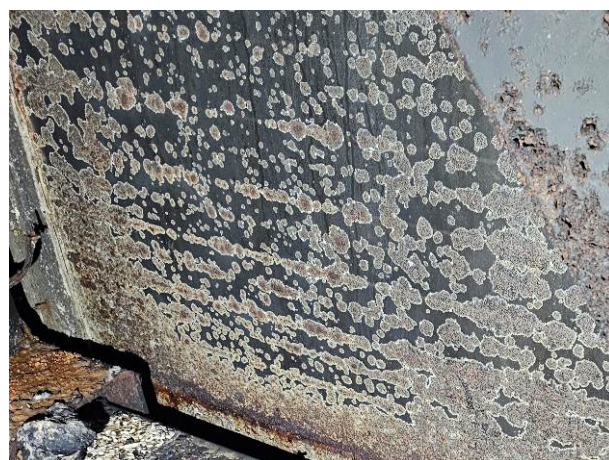
100 pav. Daugiasluoksnių plokščių vidinio paviršiaus taškinė korozija 7-oje tyrimų vietoje
