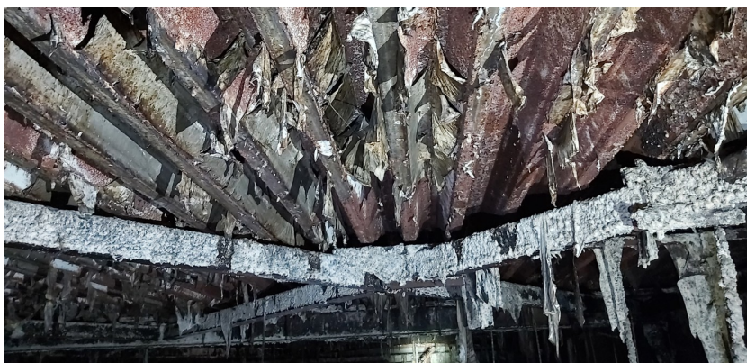
20 pav. Stogo plieninio profiliuotojo pakloto paviršiaus bendrasis vaizdas: nusilupę dažai; rūdijimo paveikti ruožai, 2026 m. vasario 19 d.
