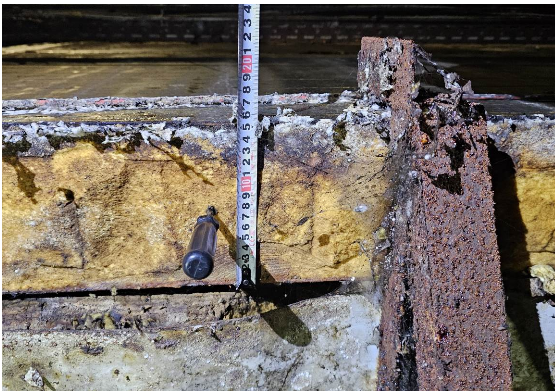
85 pav. Sieninių plokščių storio matavimai ir sudėties tikrinimas ašyje „19“
