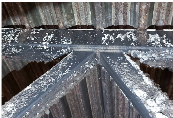
25 pav. Santvaros viršutinės juostos mazgo bei apatinės juostos mazgo vaizdai, 2026 m. vasario 19 d.
