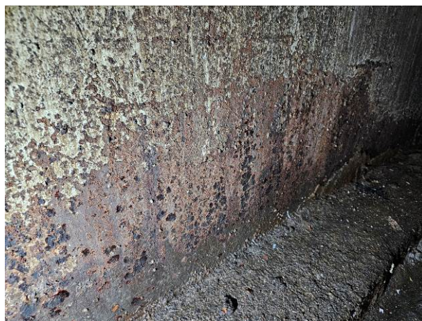
97 pav. Daugiasluoksnių plokščių vidinio paviršiaus ištisinė korozija 6-oje tyrimų vietoje
