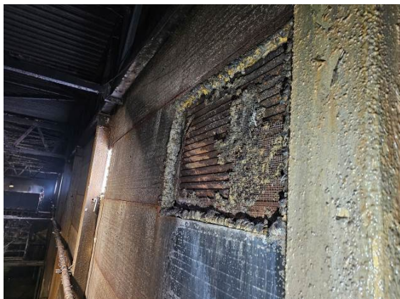
112 pav. Surūdijusios vėdinimo grotelės sienose iš patalpų pusės (2026 m.)
