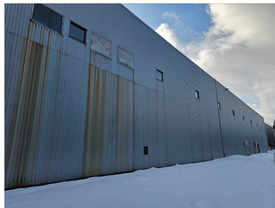
113 pav. Fasadas išteptas rūdimis, patekusiomis lauk per nesandarias angas (2026 m.)
