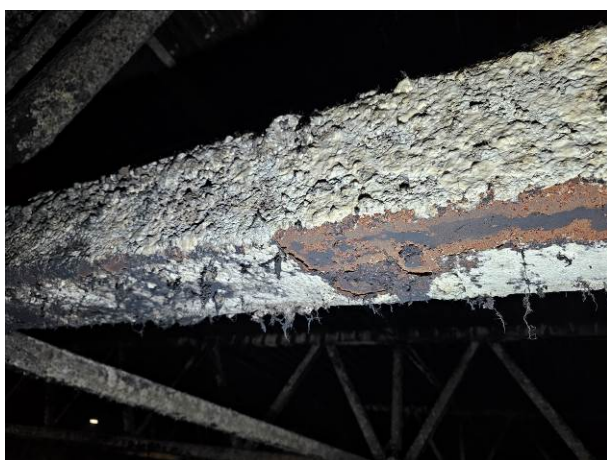
106 pav. Ištininė korozija santvaros paviršiuose 14-oje tyrimų vietoje
