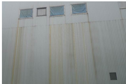
111 pav. Fasadas išteptas rūdimis, patekusiomis lauk per nesandarias angas [nuotraukos darytos 2023 metais]
