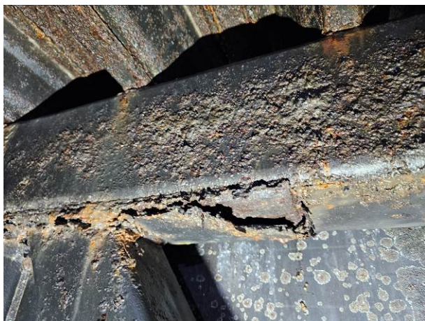
108 pav. Ištininė korozija stogo plieninių santvarų suvirinimo siūlėse
