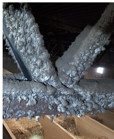
25 pav. Santvaros viršutinės juostos mazgo bei apatinės juostos mazgo vaizdai, 2026 m. vasario 19 d.
