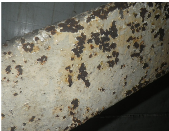
122 pav. Taškinė korozija ant plieninių ramsčių (ryšių). 2023 m. balandžio mėn.
