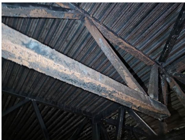
107 pav. Ištininė korozija santvaros ir posantvarės paviršiuose 24-oje tyrimų vietoje
