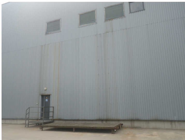
130 pav. Pastato durys yra pasidengusios baltais (iš susikondensavusių organinių medžiagų sudarytais) ruožais. 2023 m. balandžio mėn.
