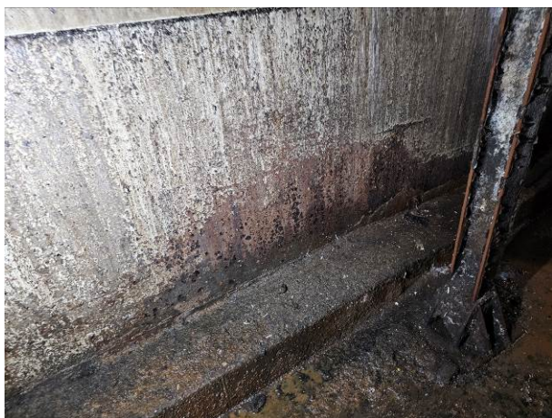
97 pav. Daugiasluoksnių plokščių vidinio paviršiaus ištisinė korozija 6-oje tyrimų vietoje
