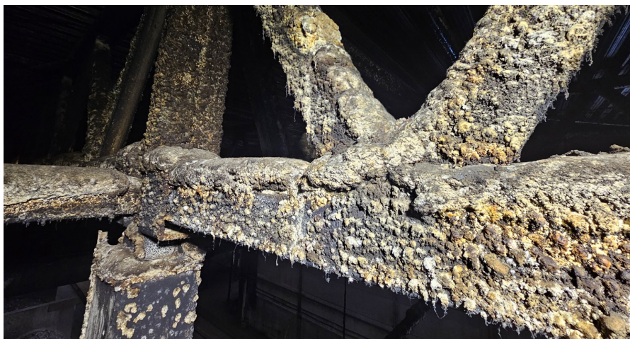
132 pav. Nusėdusiųjų organinių dulkių sluoksnis tampa maistine terpe vietoje augantiems organizmams – tiek bakterijoms, tiek grybams. 2023 m. balandžio mėn.
