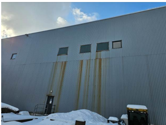
113 pav. Fasadas išteptas rūdimis, patekusiomis lauk per nesandarias angas (2026 m.)
