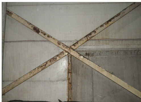
119 pav. Vartytuvo techninio aptarnavimo 1-3 patalpos kolonų plieninių ryšių (ramsčių) šoniniai paviršiai ir briaunos yra karodavusios. 2023 m. balandžio mėn.
