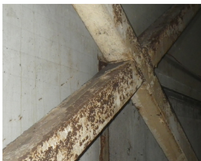
123 pav. Taškinė korozija ant plieninių ramsčių (ryšių) išilgai briaunų. 2023 m. balandžio mėn.
