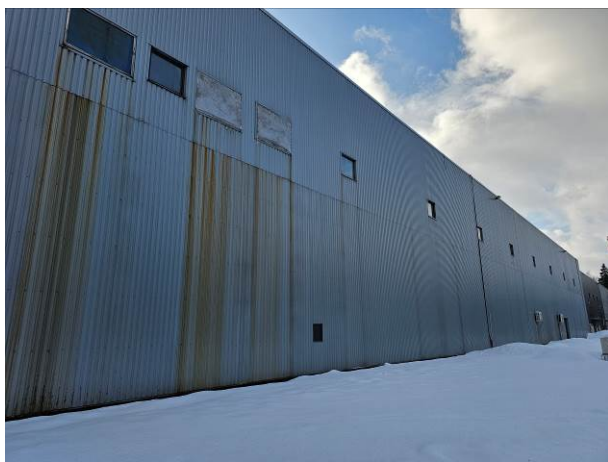
82 pav. Statinio fasadų fragmentai, įrengti iš trapecinio profilio skardos lakštų
